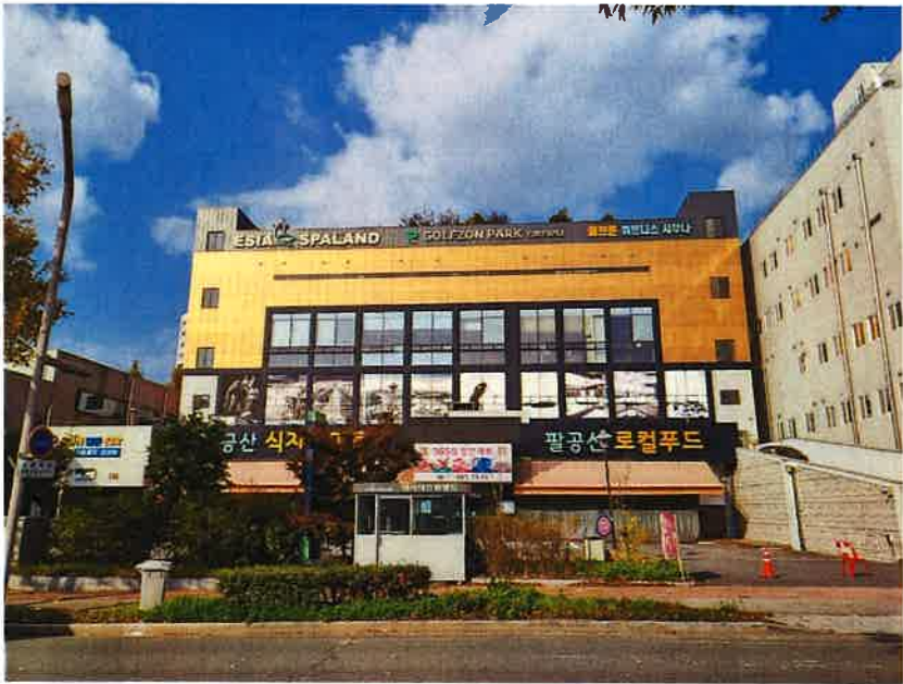
본건 외부 전경1
