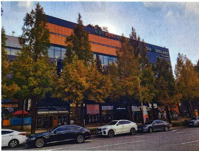
본건 외부 전경2
